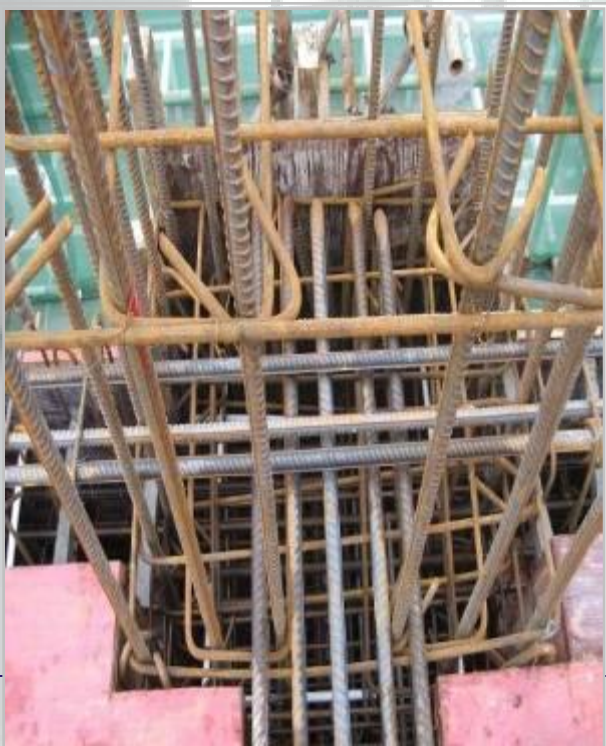
柱梁节点钢筋安装较规范
