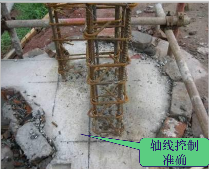
挖孔桩插筋定位较好
